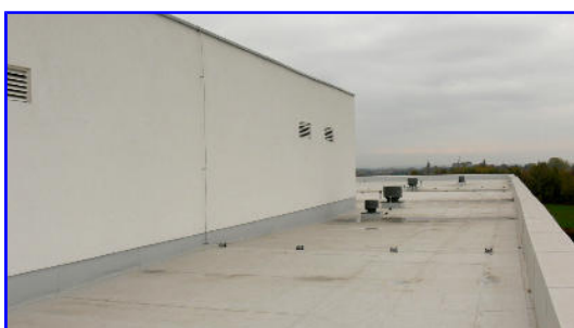
Izolačné prekrytie strechy monobloku
