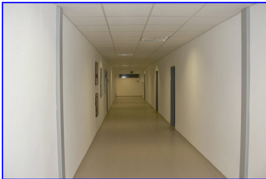
Spojovacia chodba 2. nadzemnom podlaží
