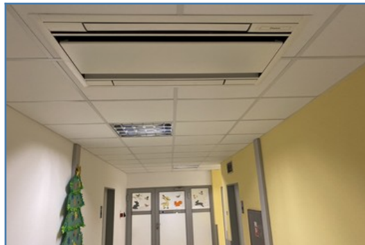
Klimatizačná jednotka na chodbe oddelenia
