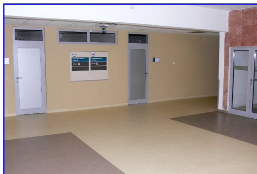
Zrekonštruované 3NP – chodba
