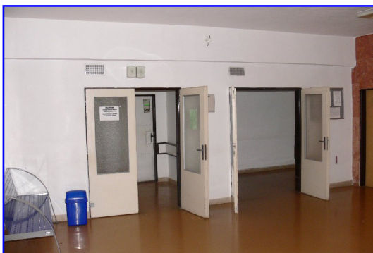
Pôvodný stav 3NP – chodba
