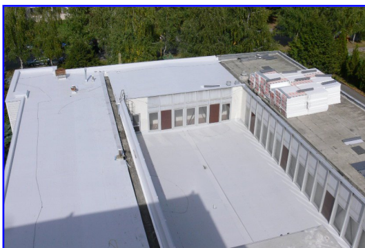
Zrekonštruovaná strecha spoločenského kridla
