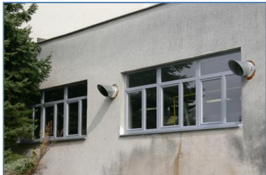
Okná na hospodárskom bloku
