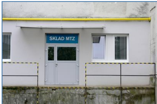
Fasáda pri sklade MTZ
