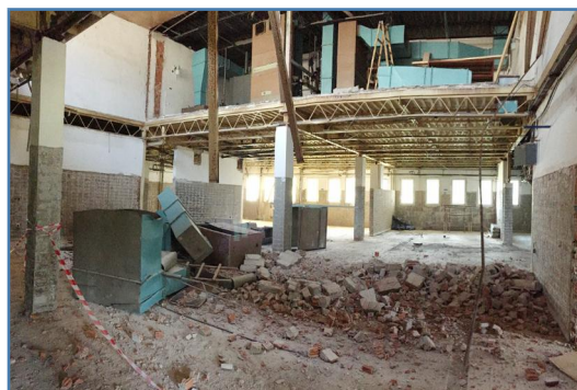
Búracie práce – pôvodný odsávací systém
