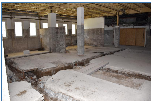
Výmena kanalizácie
