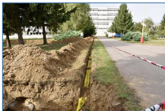
Plynová prípojka k pavilónom nájomcov
