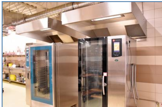
Oddelenie liečebnej výživy a stravovania – konvektomat
