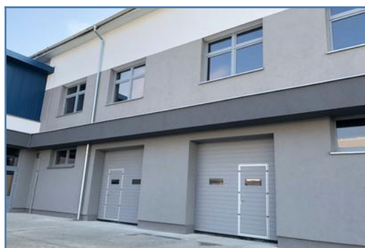
Hospodársky blok – vstupy na nájazdovej rampe
