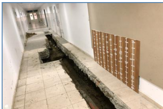
Oprava kanalizácie na prízemí monobloku
