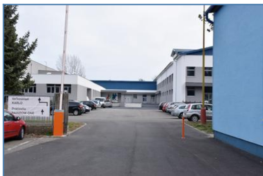
Hospodársky blok – príjazdová komunikácia s rampou
