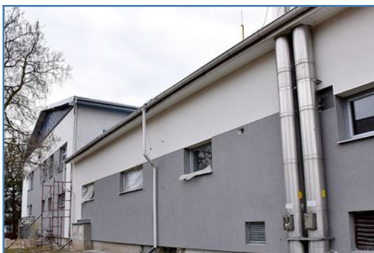
Oprava fasády východnej časti hospodárskeho bloku
