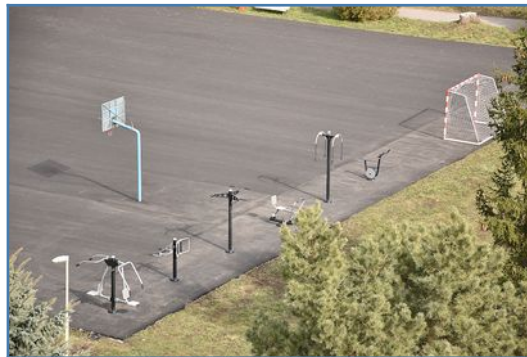
Obnova asfaltovej plochy vonkajšieho ihriska a vonkajšie cvičebné náradie
