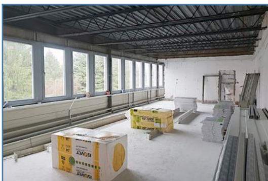
Bohoslužobná miestnosť v spoločenskom krídle počas rekonštrukčných prác
