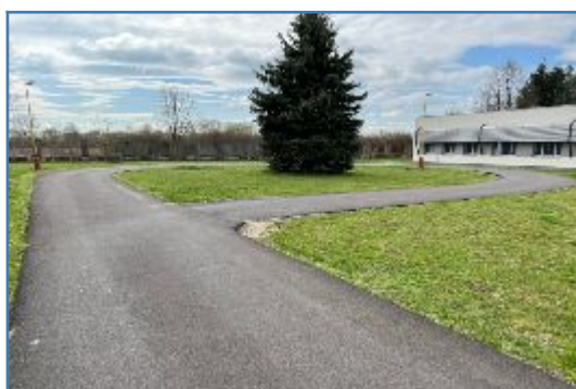
Renovovaný asfaltový povrch
