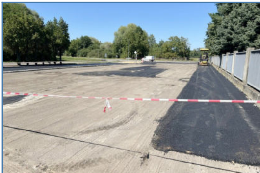
Úprava asfaltových plôch na parkoviskách – – priebeh prác
