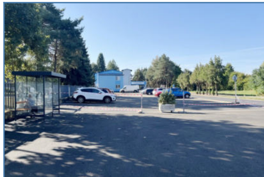
Úprava asfaltových plôch na parkoviskách – – celkový pohľad
