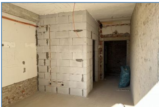
Pavilón C – Psycho-sociálne centrum Michalovce (rekonštrukčné práce)
