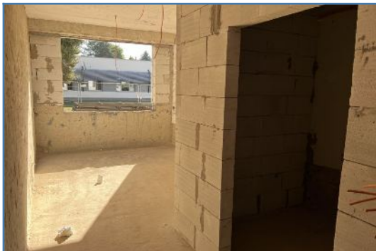
Pavilón C – Psycho-sociálne centrum Michalovce (rekonštrukčné práce)
